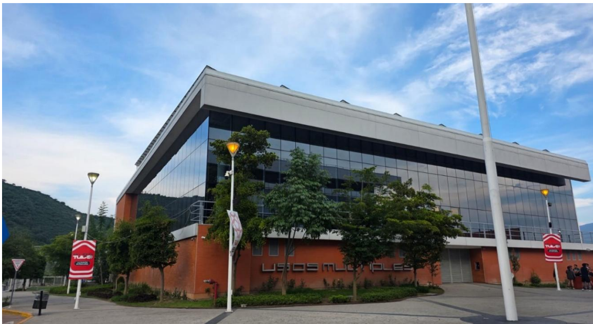
Salón de Usos Múltiples (SUM), del Centro Administrativo de Tlajomulco (CAT).
